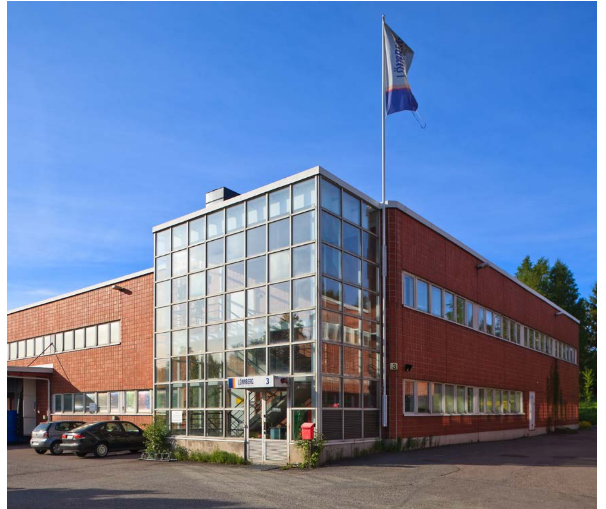
Kiinteistö Oy Helsingin Hiekkakiventie 3
