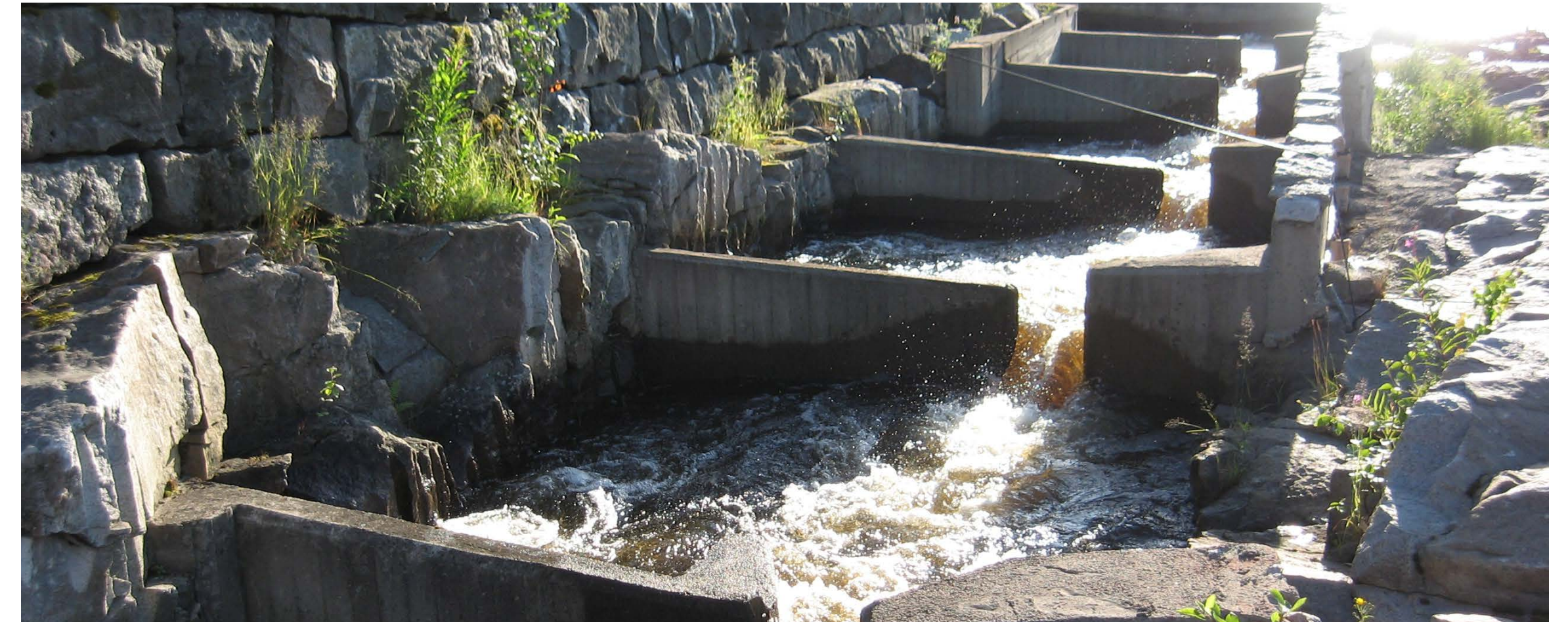
Kalaportaita Oomin Merikosken vesisähkövoimalasta
