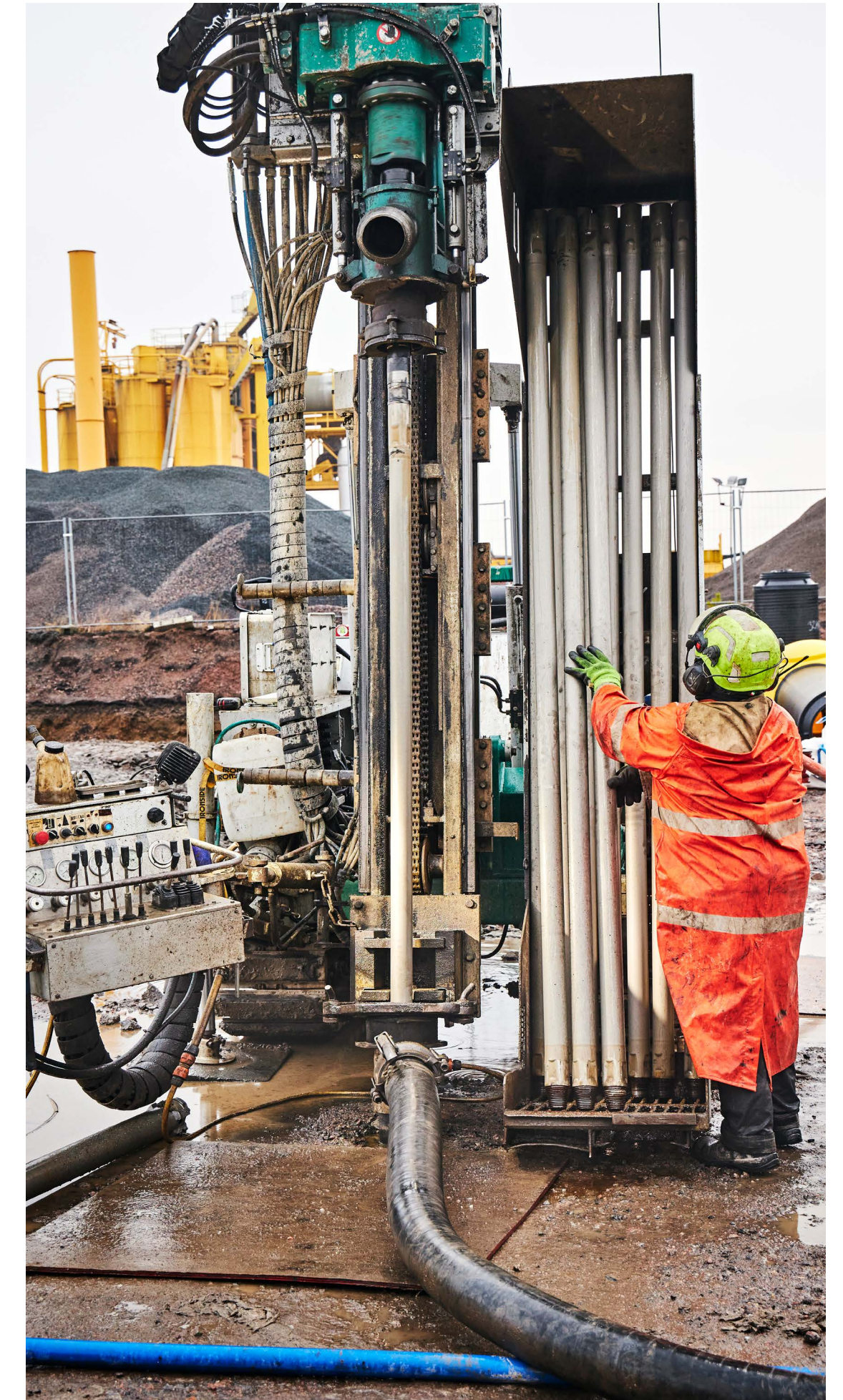
Maalämmön asentamista K0y Tuusulan Högbergintie 5:ssä
